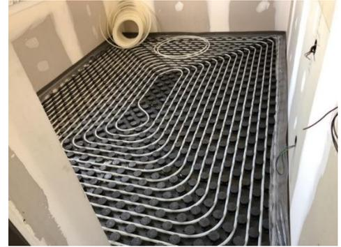
h. Para la conexión de los tubos emisores al colector, hay que utilizar los conectores adecuados a la rosca de la conexión y al diámetro del tubo emisor, de forma que la conexión sea hermética, resistente y segura. El accesorio tiene que entrar recto en el colector para evitar cualquier problema de pellizcamiento de juntas. Una vez unido uno de los extremos del tubo al colector, se une el otro extremo al colector de retorno.
