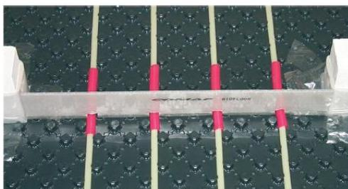
La superficie entre juntas de dilatación no debe superar los 40 m<sup>2</sup>, con una longitud máxima de 8 m. Se deberán colocar en los pasos de puertas siempre que la longitud del recinto sea superior a 3 veces su anchura.
