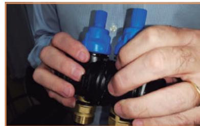
3. Colocar la grapa de fijación, presionando. Realizar la misma operación con el resto de módulos.
