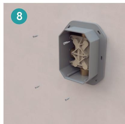
**8** Fijar la caja iClever mediante tornillos.
